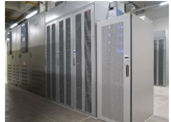
MW级发展所ESS ( 储能系统 ) 建造
